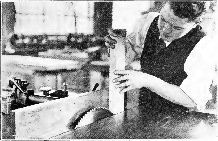
FIG. 168. SAWING TENON.
